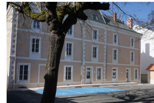
Ecole Paul Bert à Châtellerault Production de 15 logements
